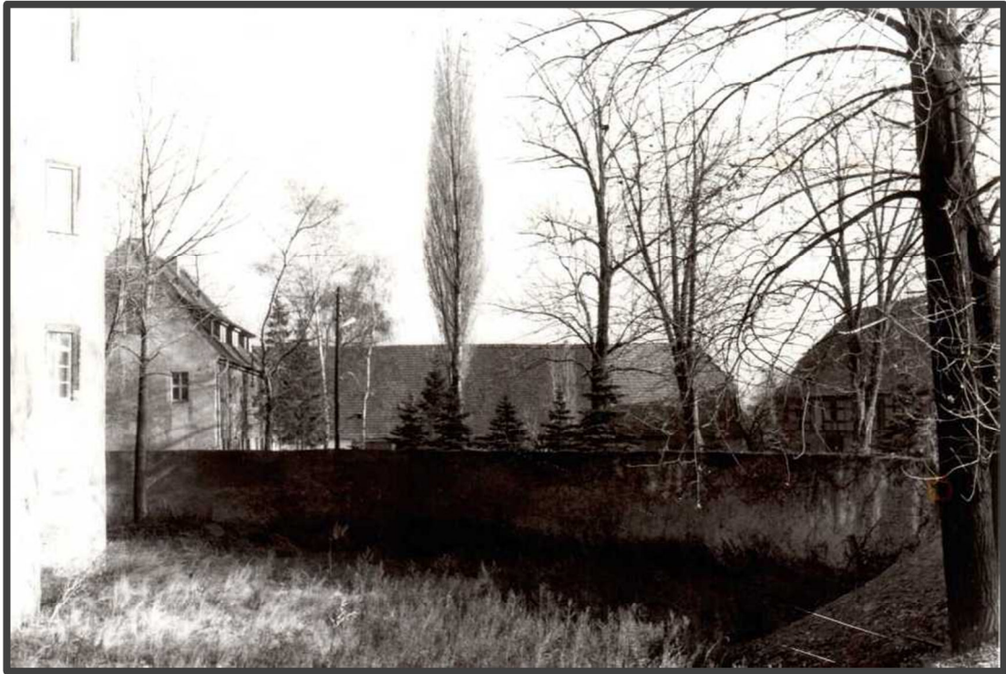
Ehemalige Wirtschaftsgebäude von Schloß Großmehlen
