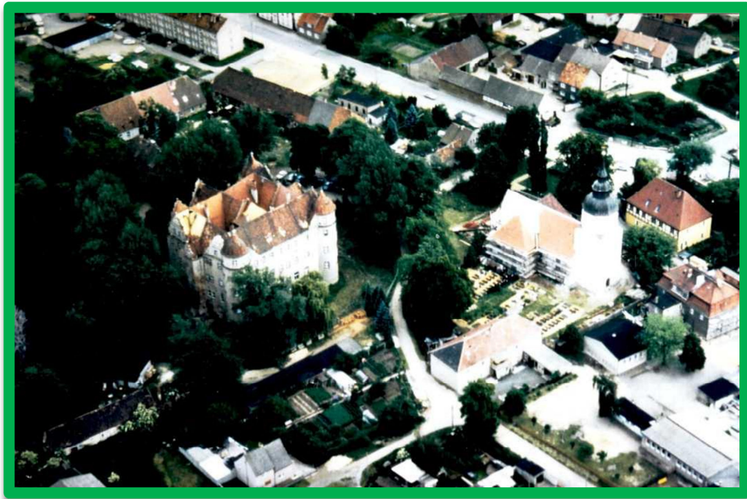
Schloß Großmehlen mit Wirtschaftsgebäuden, Kirche St. Georg (Luftbild)
